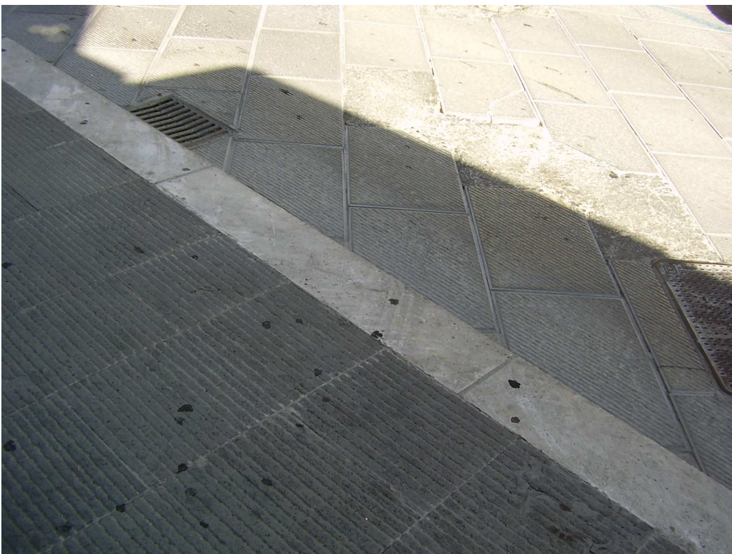
Foto 4 – Particolare pavimentazione Via Verdi
